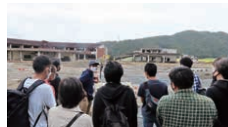
津波で84名が犠牲となった大川小学校では震災遺構として保存するための工事が始まっています
